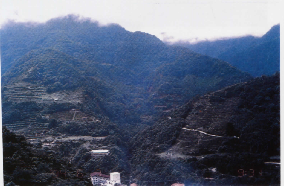
照片二、盧山溫泉(馬海僕溪上游)舊山崩情形
